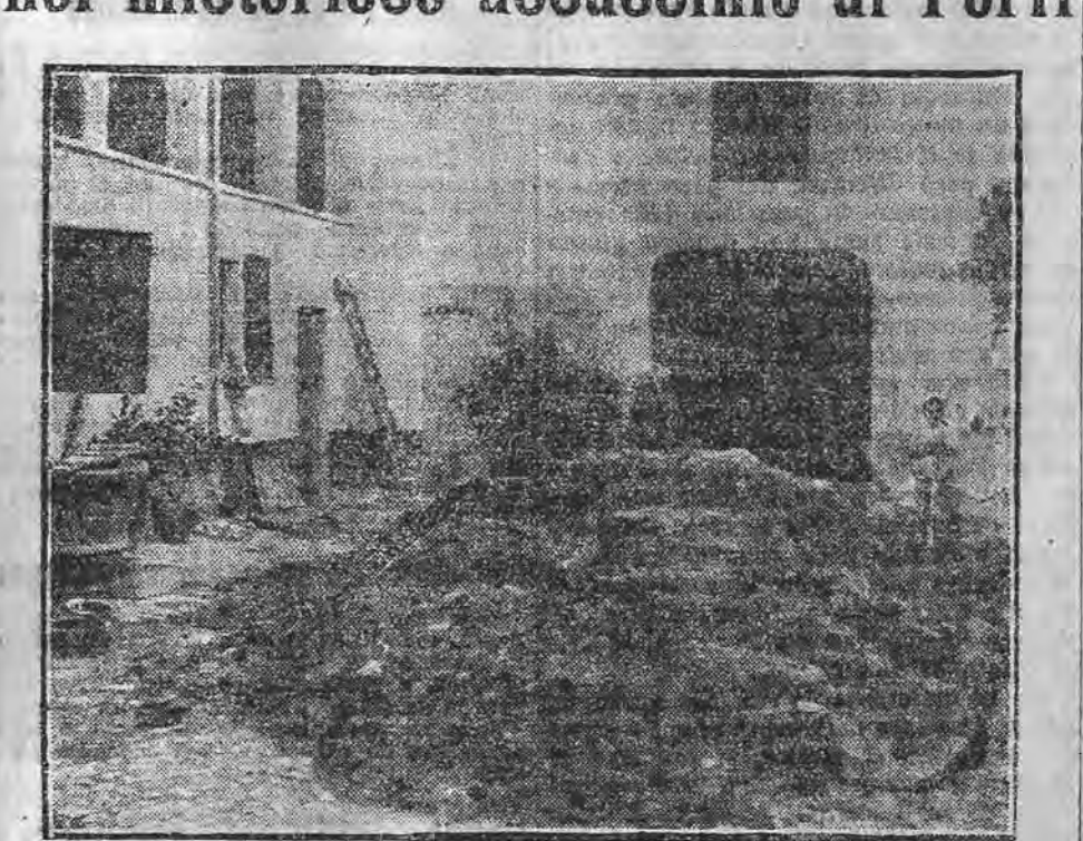
I lavori di sterro nel cortile della casa Malmesi.
