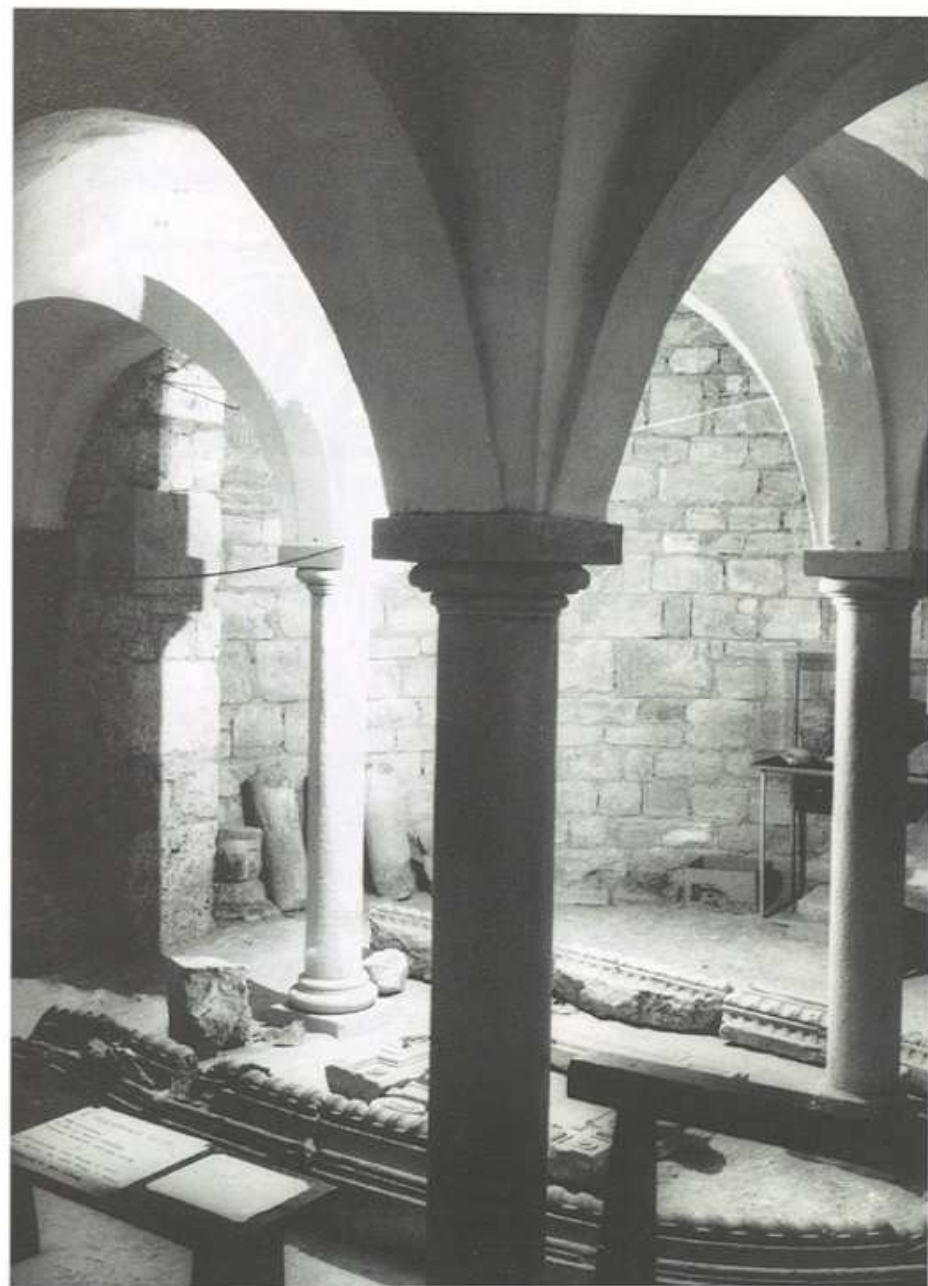
L'interno della cripta romanica in parte distrutta per cause belliche e ricostruita nel dopoguerra. Alle pareti conserva i capitelli e le colonne originali, mentre quelle centrali sono frutto della ricostruzione.
