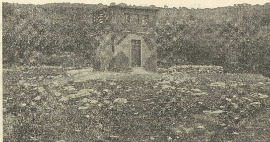
Fig. 6. - Coloritura mimetica di una cabina di trasformazione.
