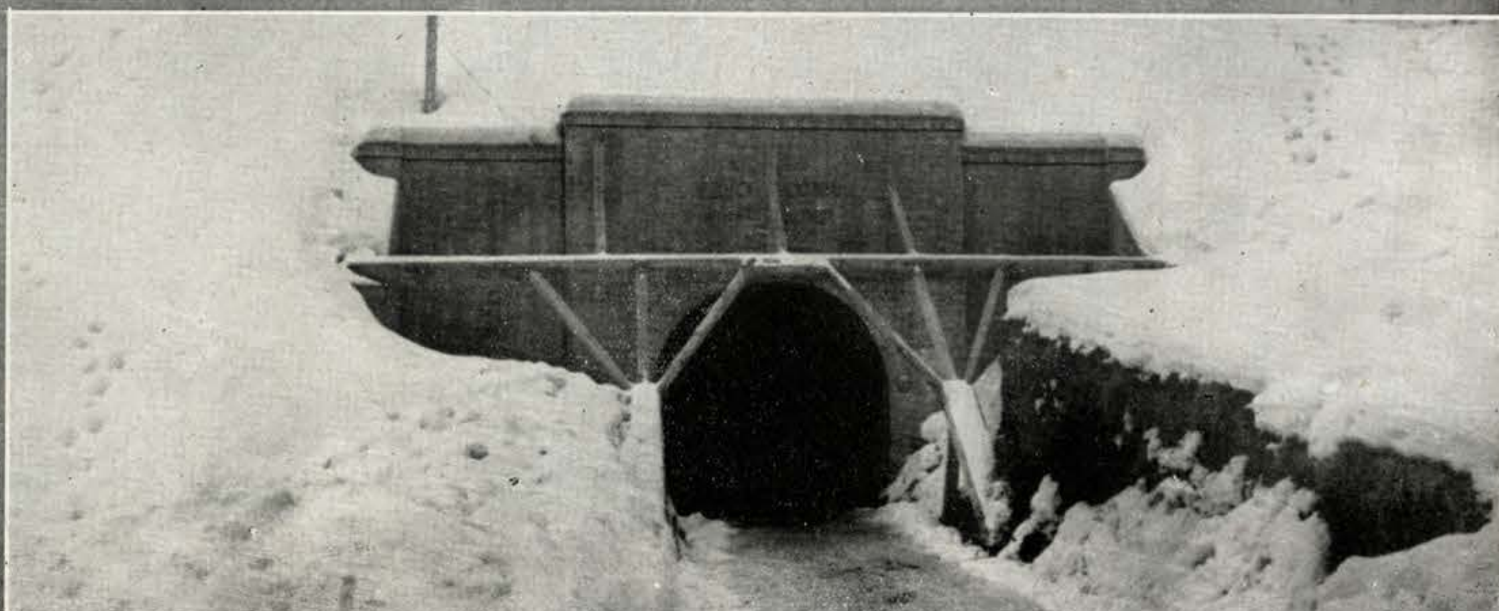
Ricoveri in Galleria "Renato Rosso,, - Via Vallescura • "Bartolo Tommasino,, - Viale Risorgimento "Ezio Biondi,, - Via Cino da Pistoia
