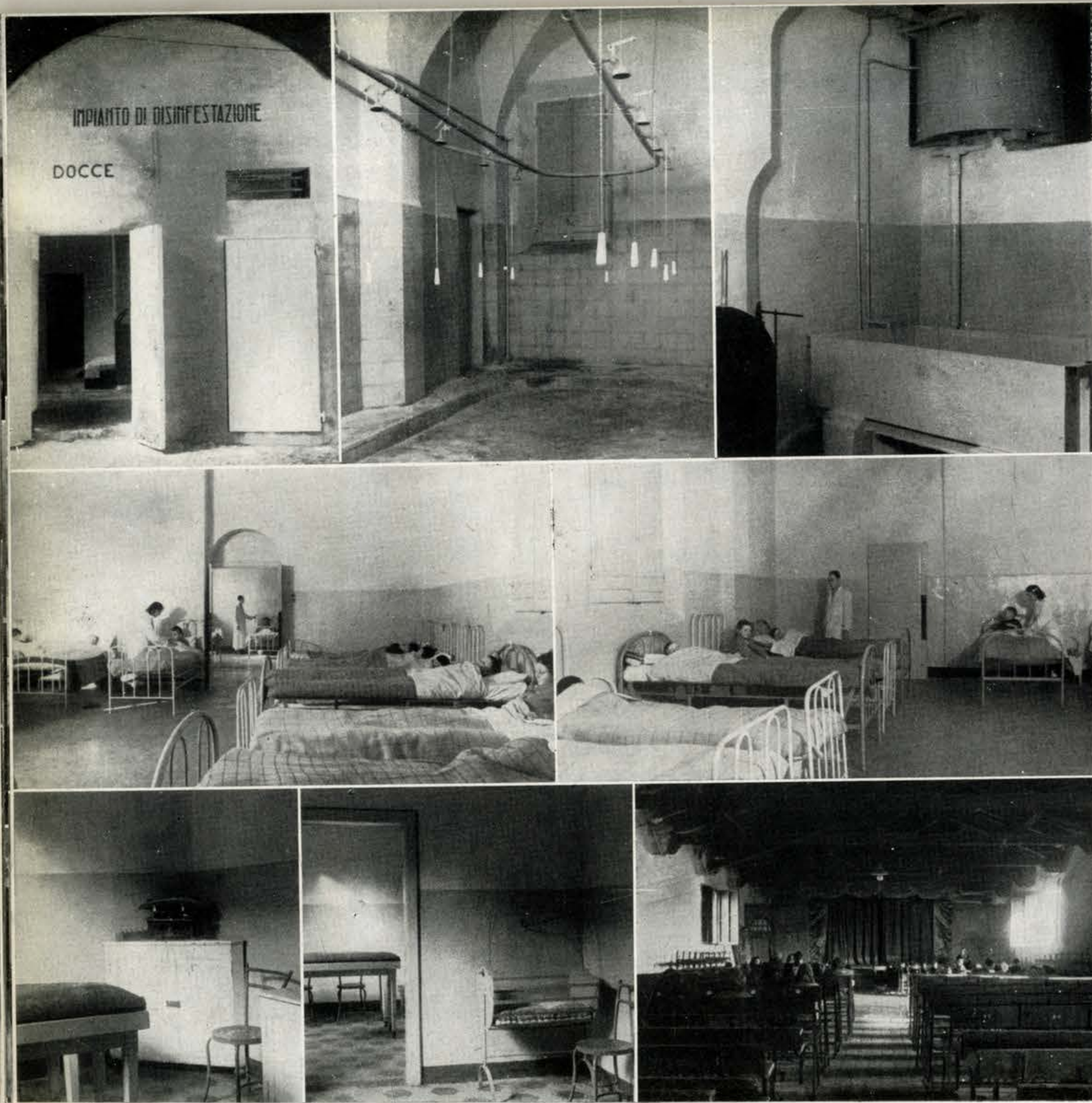
Impianti Sanitari di disinfestazione - Ambulatori e Cinema - Caserma "Giordani,, - Via S. Margherita
