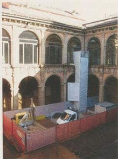
Fig. 1 – Il cantiere e il ponteggio nel cortile dell'Archiginnasio per la realizzazione del montacarichi di collegamento fra il primo e il secondo piano (foto Marcello Fini del 4 febbraio 2009).
