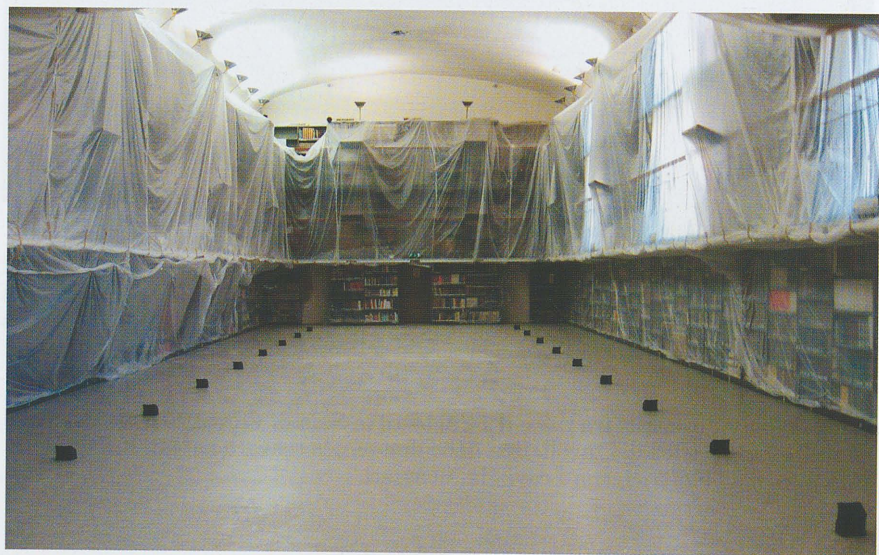
Fig. 8. Settembre 2008: la Sala di Consultazione, al termine dei lavori, con le nuove torrette elettriche per l'alimentazione dei tavoli e il soffitto ridipinto.
