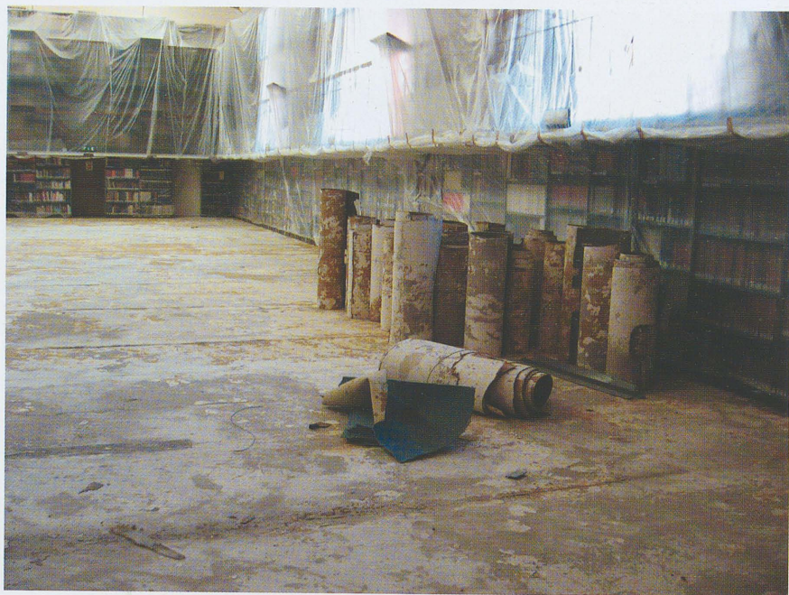
Fig. 5. 4 agosto 2008: la Sala di Consultazione con il massetto messo a nudo dopo la rimozione del vecchio rivestimento in linoleum, accatastato in rotoli in attesa dello smaltimento.
