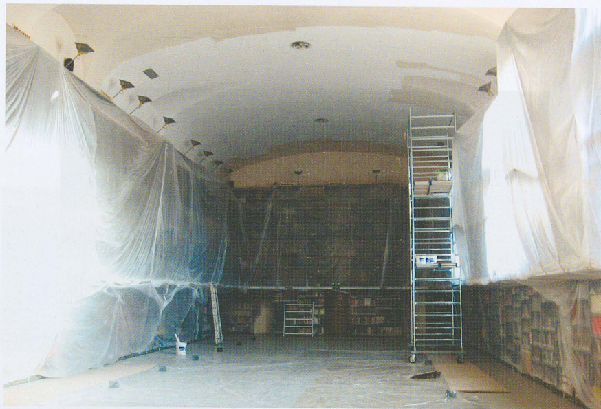
Fig. 7. I lavori di tinteggiatura del soffitto in Sala di Consultazione eseguiti fra il 28 agosto e il 2 settembre 2008.
