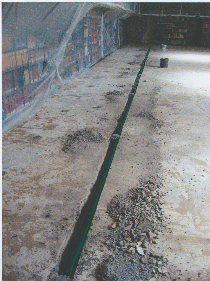
Fig. 6. I lavori, eseguiti fra il 5 e il 14 agosto, in Sala di Consultazione per l'alimentazione elettrica dei tavoli: una delle due tracce scavate nei lati lunghi della Sala per i cavi elettrici, con i cavi già incassati.
