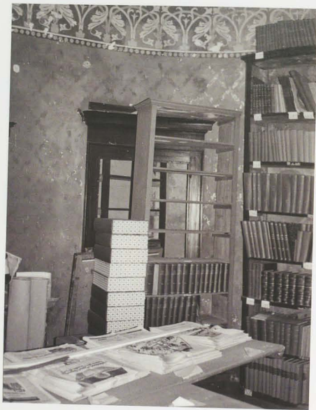
Fig. 2. La sala ovale del secondo piano, antica sala da pranzo di Luigi Frati, in una foto realizzata nel 1980.
