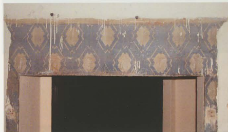
Fig. 5 - Anche sotto il telaio della porta di accesso alla «Rotonda», nell'atrio, è riemersa la decorazione a rullo, probabilmente del 1861, caratterizzata in questo ambiente da una decorazione con strane figure geometriche (una sorta di tozze croci greche) ordinate disposte a reticolato su un luminoso fondo celeste.
