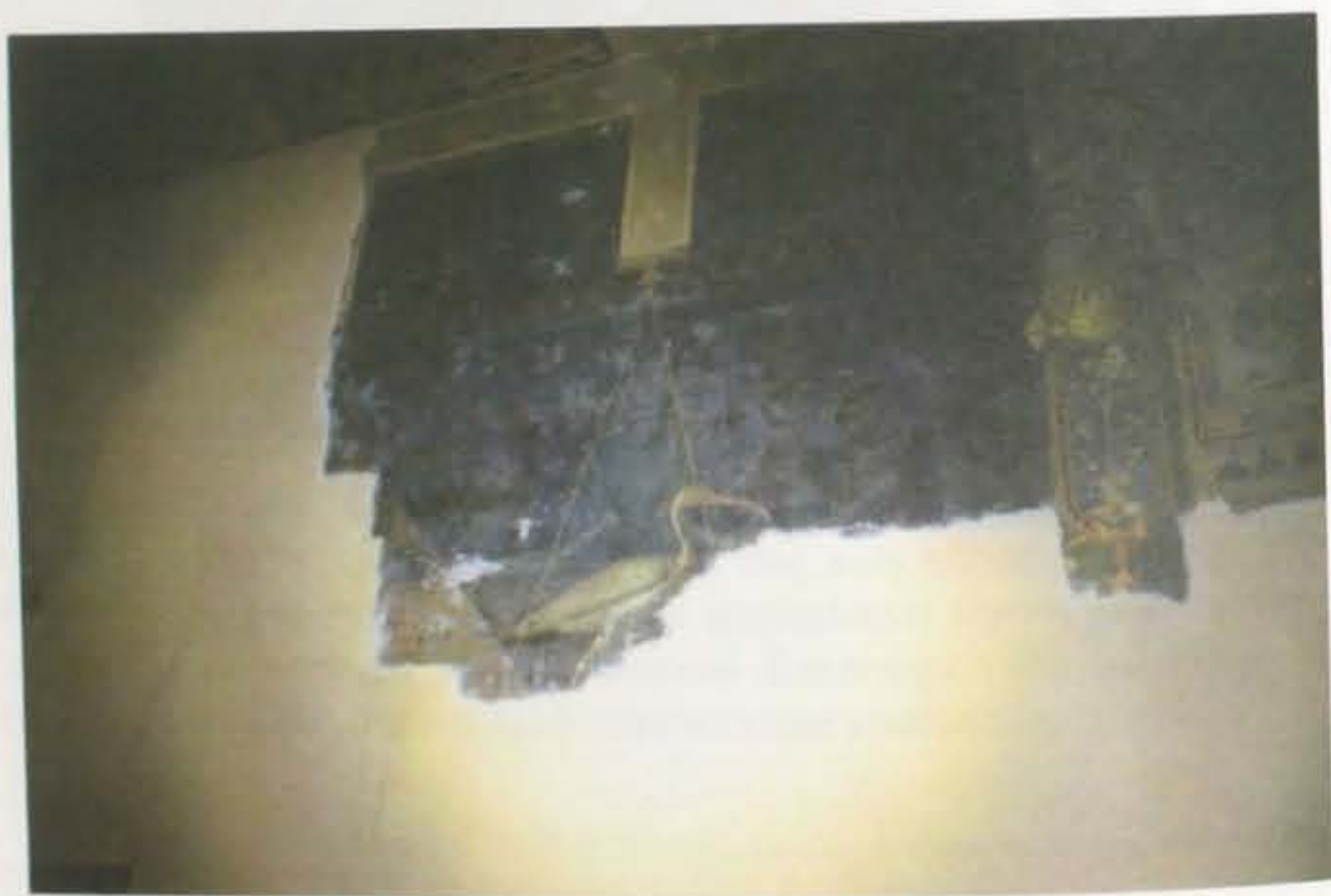
Fig. 3. Eliminazione della scialbatura sulla parete a sinistra della finestra (foto Tecton).
