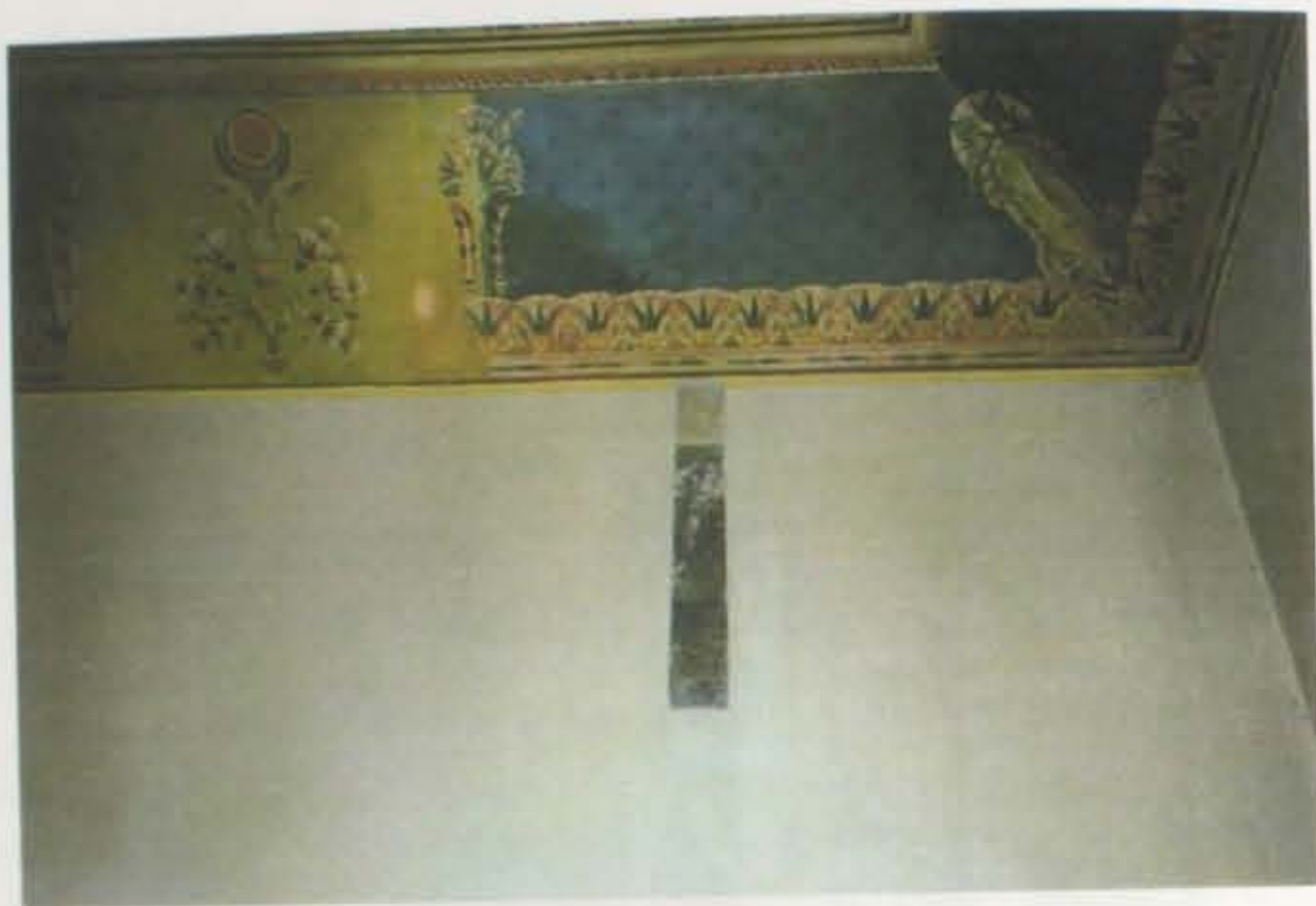
Fig. 2. Palazzo Riario Aldini Sanguinetti, Bologna, saletta egizia: primo tassello di pulitura al di sotto del soffitto decorato (foto Tecton).
