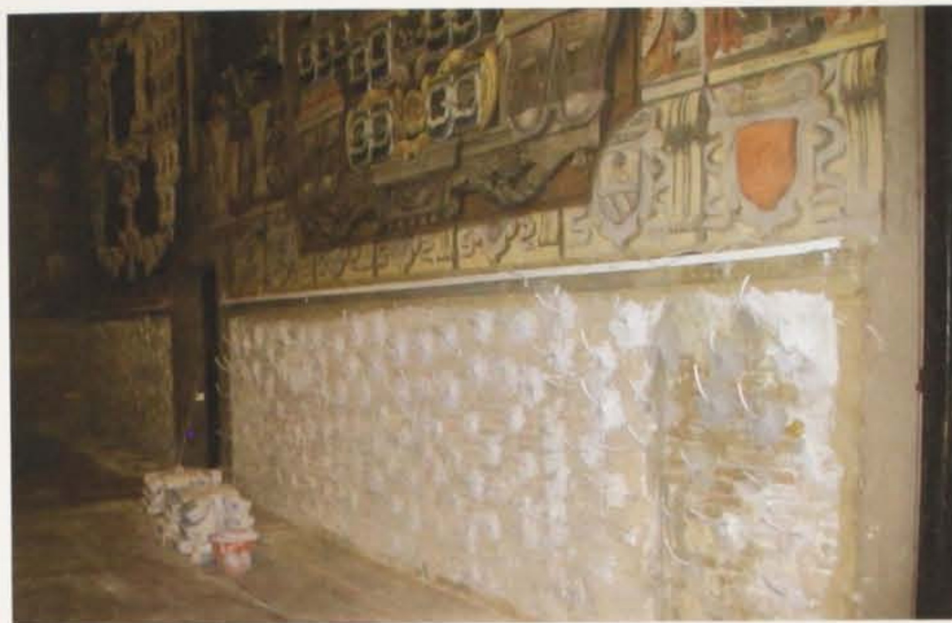
Fig. 4 - Iniezioni consolidanti al muro settentrionale della sala dello Stabat Mater.
