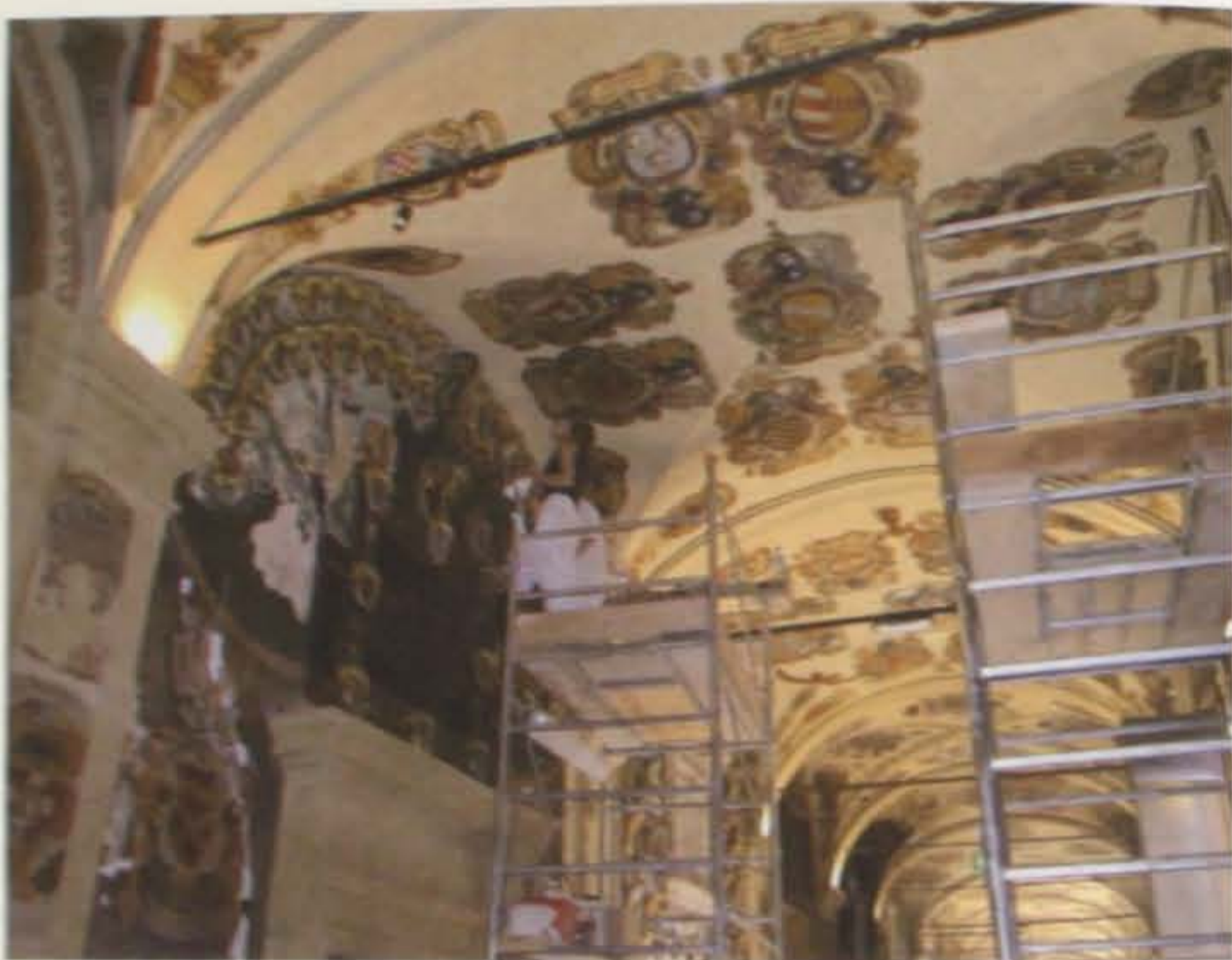
Fig. 3 - Il monumento in onore di Lorenzo Cavallina, nell'ambulacro dei Legisti, durante i lavori di restauro.
