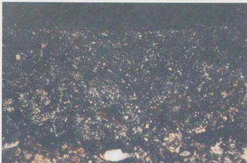
Fig. 2. Esempio di strato superficiale degradato, con formazione di crosta nera su un substrato calcarenitico.
