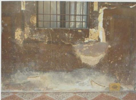
Fig. 1. Lato settentrionale del quadriloggio inferiore, arcata V. Degrado delle stuccature eseguite a cemento.
