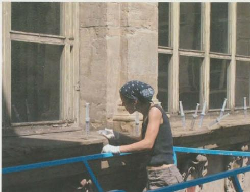
Fig. 3. Il restauro delle arenarie esterne del quadriportico tramite iniezioni consolidanti.
