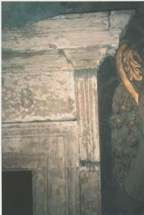
Fig. 14. Porta del *Cubiculum Iuristarum* con evidenti fenomeni di alterazione superficiale.
