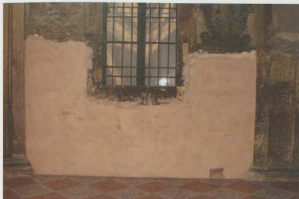
Fig. 3. Lato settentrionale del quadriloggato inferiore, arcata V. Stuccatura con «albazzana».
