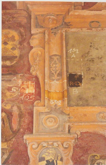
Fig. 6. Lato settentrionale del loggiato inferiore, arcata VI, monumento a Giovanni Battista Irrigo. Stratigrafie di pulitura.
