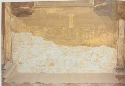
Fig. 2. Lato settentrionale del quadriloggato inferiore, arcata VIII. Rimozione delle stuccature cementizie.
