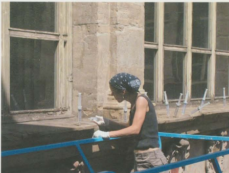
Fig. 3. Il restauro delle arenarie esterne del quadriportico tramite iniezioni consolidanti.
