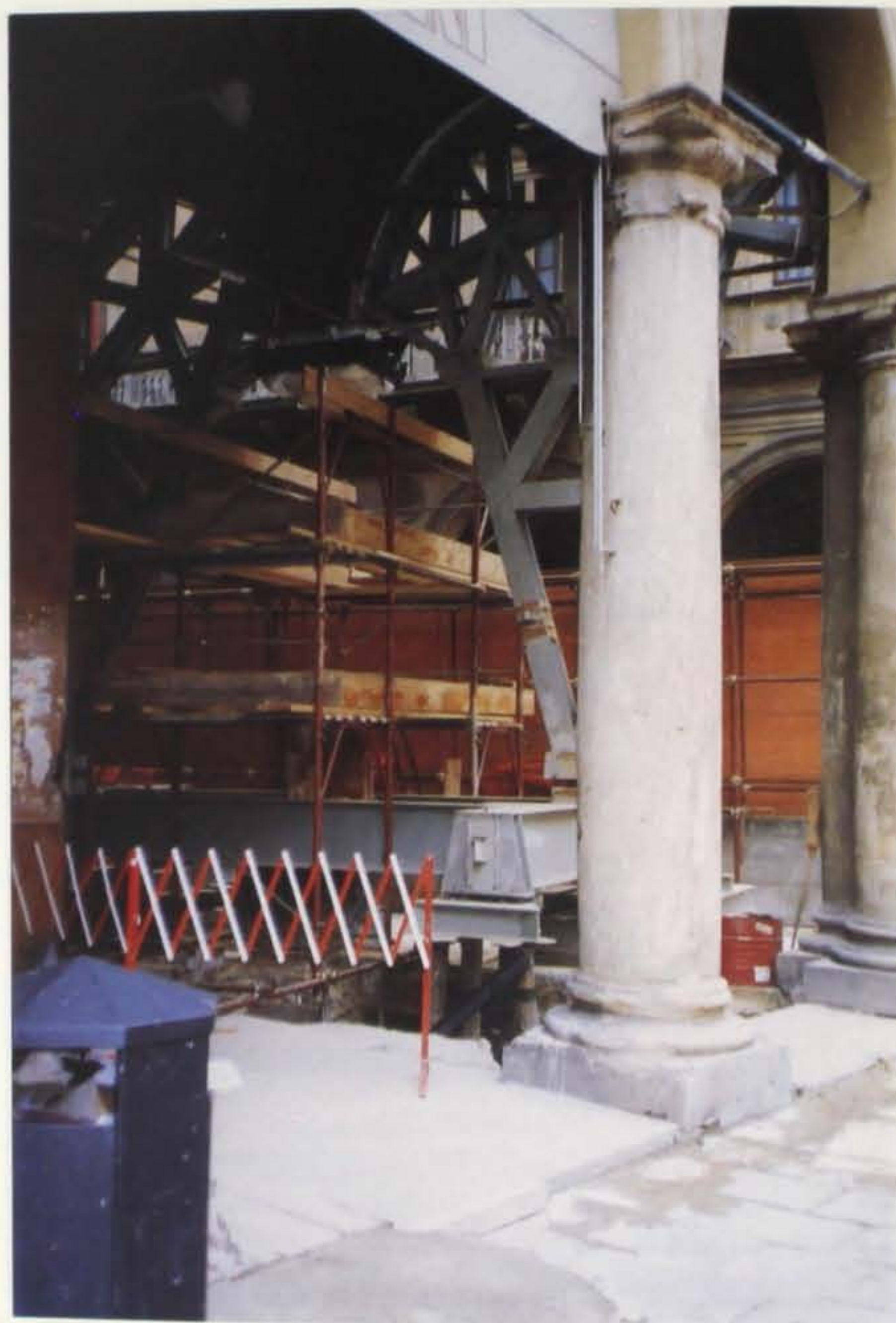
Tav. 1. Angolo fra via Farini e piazza Galvani (foto eseguita il 25 settembre 2002): al muro meridionale della Sala dello Stabat Mater sono state tolte le colonne di sostegno per effettuare lavori di consolidamento.
