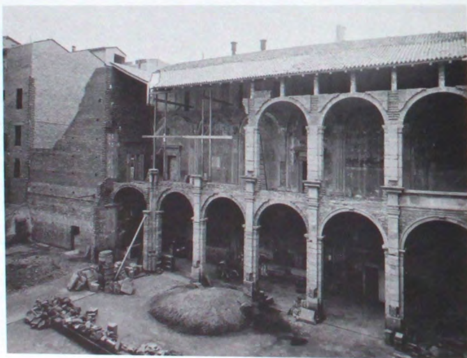
Palazzo dell'Archiginnasio. Lavori di ricostruzione del lato meridionale del loggiato. (S.B.A.A.E., Archivio fotografico)
