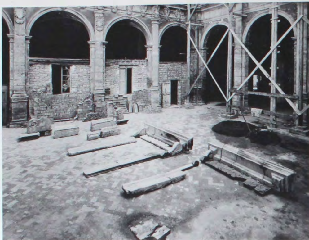
Palazzo dell'Archiginnasio. La ricomposizione delle cornici dei portali, durante i lavori di restauro. (B.C.A.B., G.D.S., Fondo Franco Bergonzoni)
