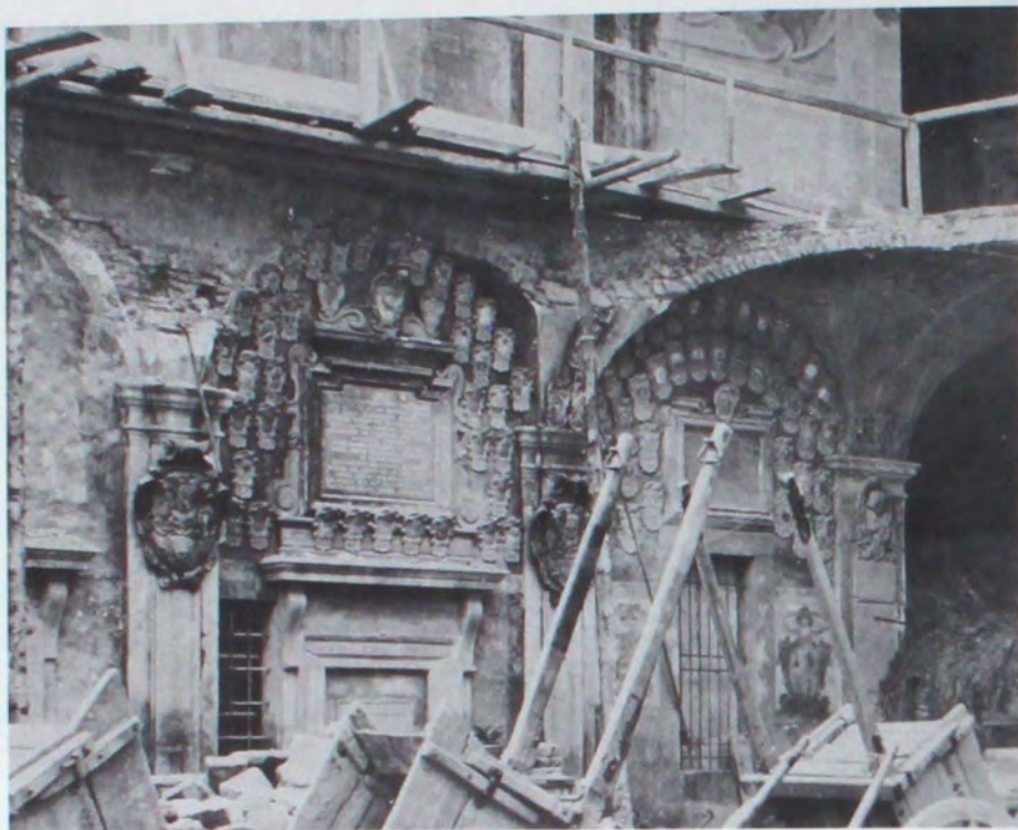
Palazzo dell'Archiginnasio. Particolare del loggiato meridionale al pian terreno dopo il bombardamento del 29 gennaio 1944. Sulla destra è visibile il fienile cui era annessa una stalla, di cui parlò il Soprintendente Alfredo Barbacci nella sua relazione al Ministero dell'Educatione Nazionale denunciando il degrado dell'edificio. (B.C.A.B. , G.D.S., Fondo Franco Bergonzoni)
